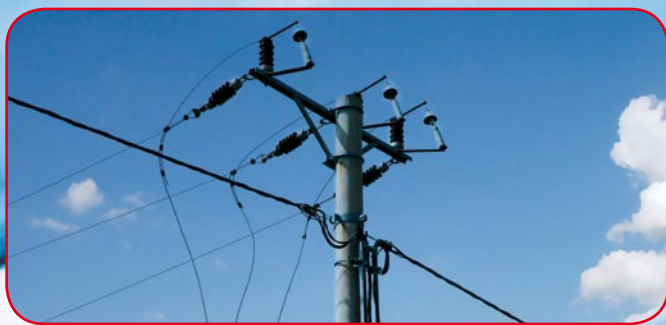
Stacja transformatorowa STSu-15/0,4 przed modernizacją
