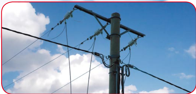
Uproszczona słupowa stacja transformatorowa STSuz-15/0,4 wg rozwiązania Koncernu Energetycznego ENERGA S.A. – Oddział w Toruniu, z zamontowanymi ogranicznikami typu ASI
