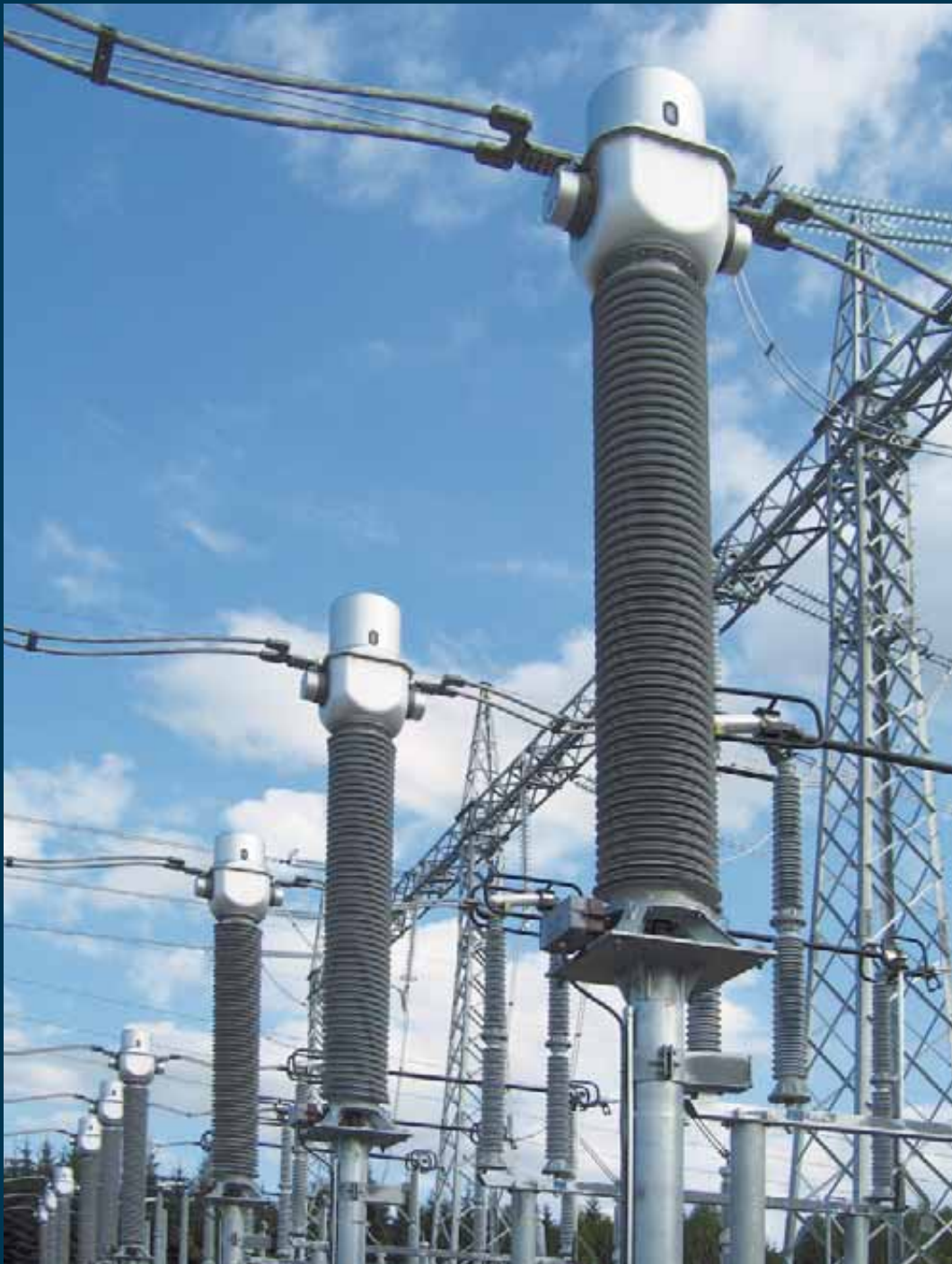
› Przekładniki prądowe 420 kV z izolatorem z gumy silikonowej w szarym kolorze. Statnett (Norwegia).
