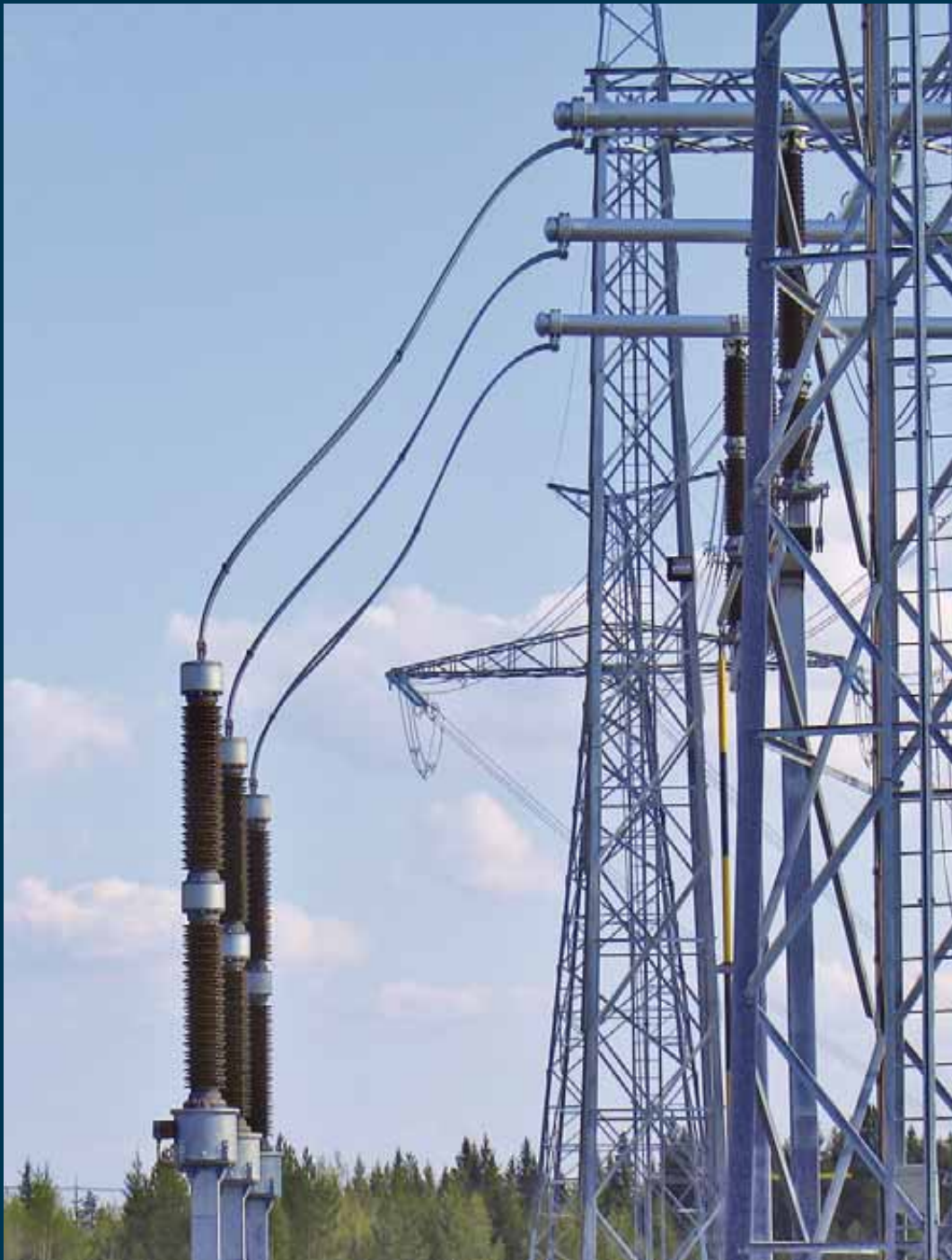
› 420 kV Pojemnościowe przekładniki napięciowe. Fingrid, Visulahti (Finlandia).
