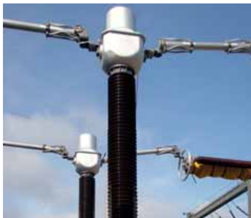
3. 420 kV Przekładniki prądowe. National Grid (Wielka Brytania).
