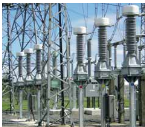
2. 123 kV Indukcyjne przekładniki napięciowe. Transpower (Nowa Zelandia).
