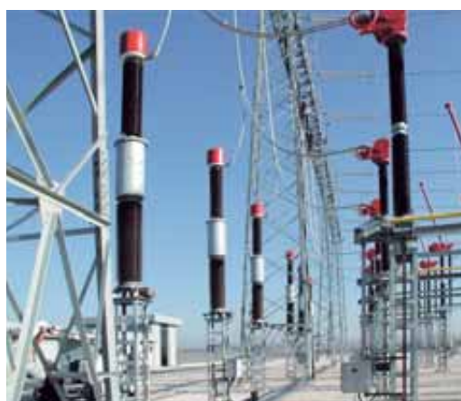
3. 420 kV Indukcyjne przekładniki napięciowe. Rede Eléctrica Nacional (Portugalia).
