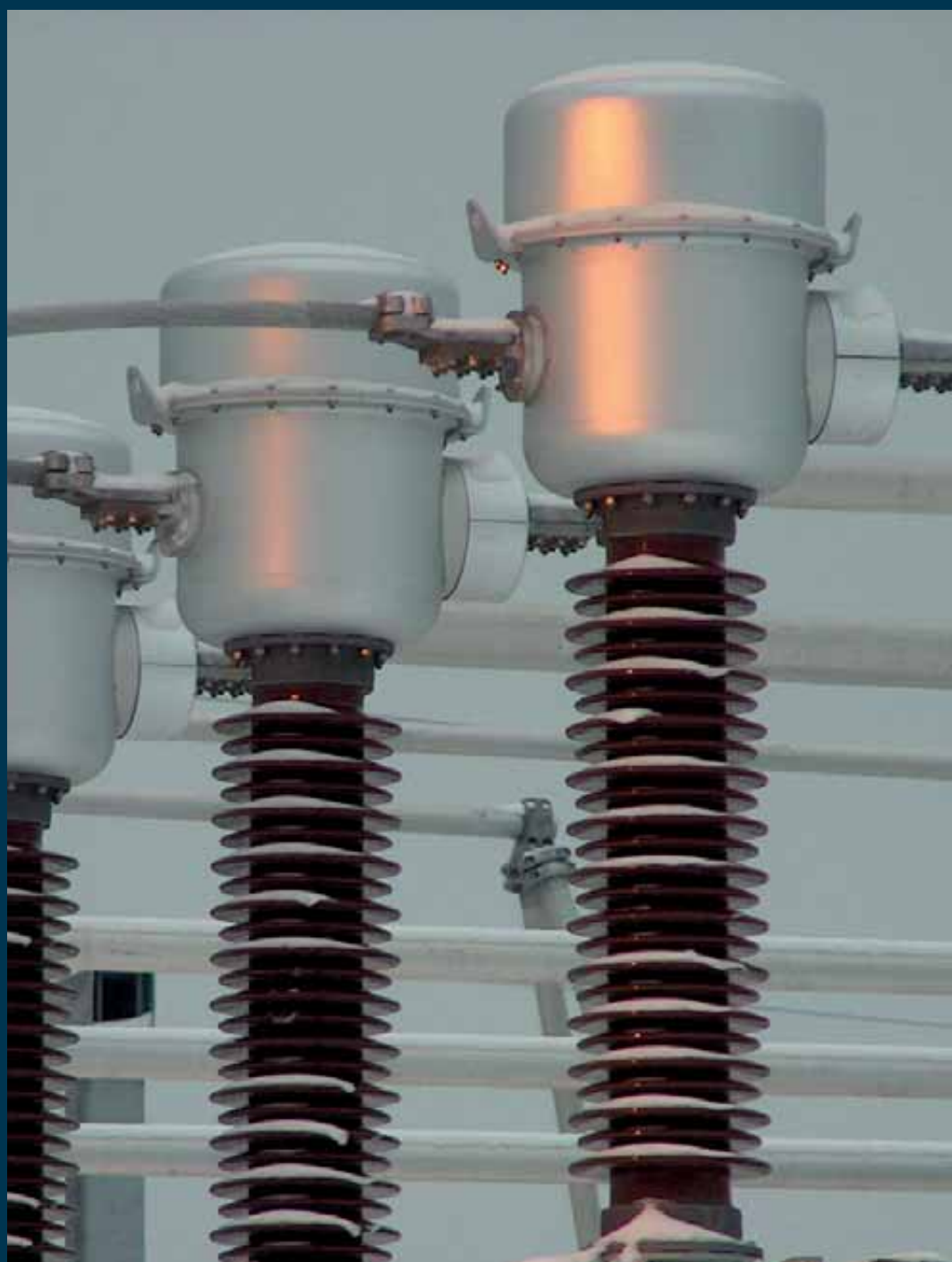
› 123 kV Przekładniki kombinowane.
