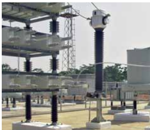
2. 245 kV Przekładnik prądowy zabezpieczający baterię kondensatorów (Indie).
