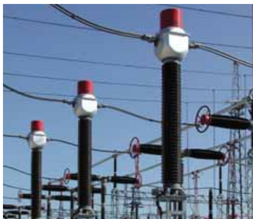
4. 420 kV Przekładniki prądowe. Rede Eléctrica Nacional (Portugalia).
