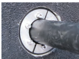
Widok i gabaryty przepustu niskiego napięcia (GPK - 110)
