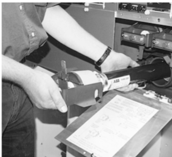
6. Wyciągnąć dźwignię. Wkładka jest sztywno osadzona w pokrywie komory bezpiecznikowej.
