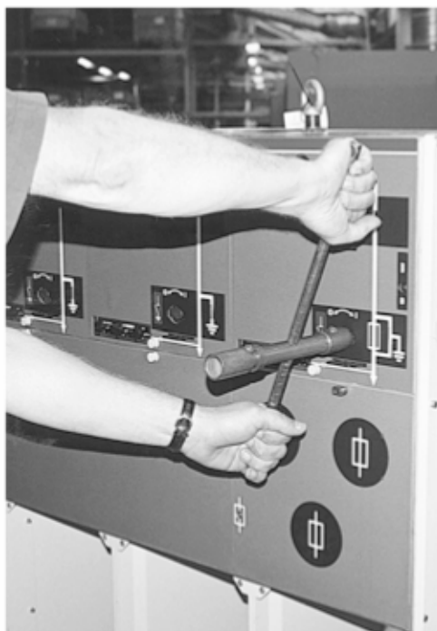
2. Zamknąć uziemnik poprzez obrót dźwigni operacyjnej zgodnie z ruchem wskazówek zegara.
