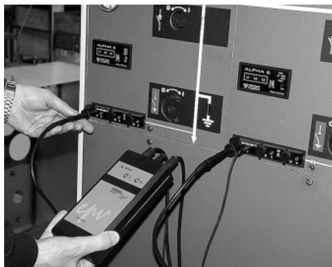
Uzgadnianie faz przy użyciu uzgadniacza typu EPV firmy Pfisterer lub ORION 3.0 firmy Horstmann.
