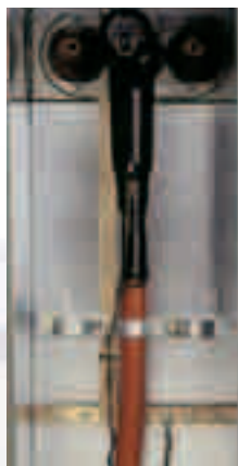
Szczegóły połączenia: EUROMOLD (K-400TB) Przykręcana głowica kąтова
