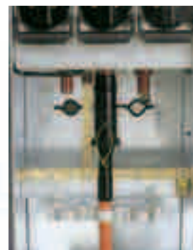
Szczegóły połączenia: EUROMOLD (K-152SR) Wciskana głowica kąтова
