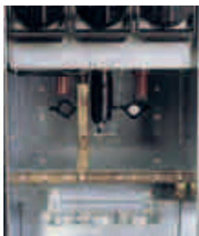
Szczegóły połączenia: EUROMOLD (K-158LR) Wciskana głowica kąтова
