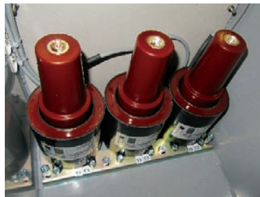
Stożek przyłączeniowy typu C Pole wyłącznikowe 500 A wyposażone w zabezpieczeniowe przekładniki prądowe
