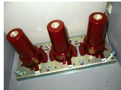
Stożek przyłączeniowy typu C Pole rozłącznikowe 630 A bez przekładników prądowych
