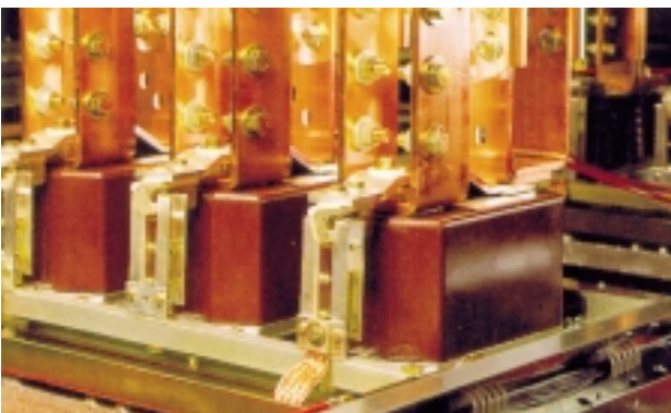
Uziemnik zespolony z przekładnikami prądowymi
