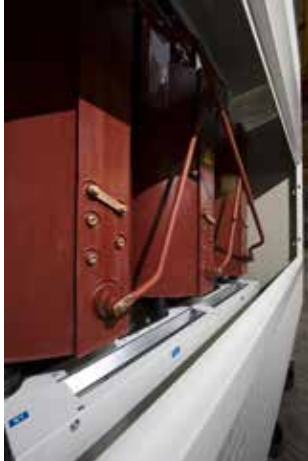
Transformator z wentylacją wymuszoną w obudowie IP31
