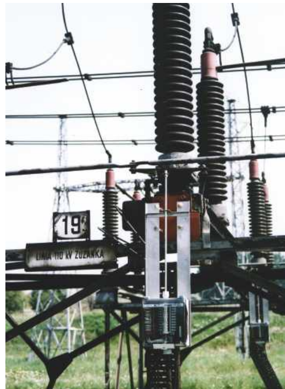
Zespół O/110/ PS-0/1 na odłączniku 110 kV
