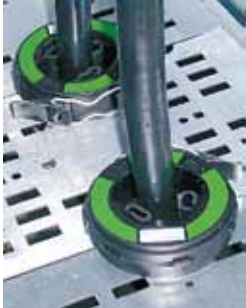
Przekładniki prądowe toroidalne
