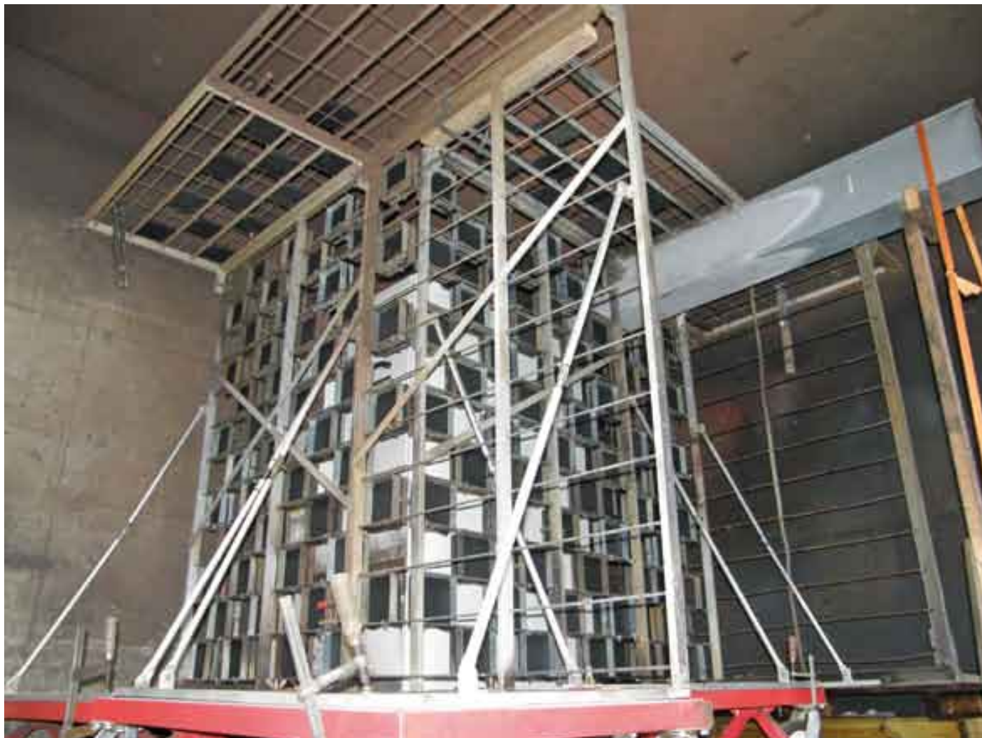
Rozdzielnica przygotowana do próby odporności na wewnętrzny łuk elektryczny
